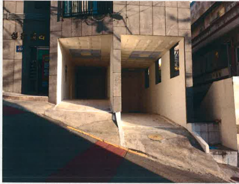
【본건 지하부분 전경】
